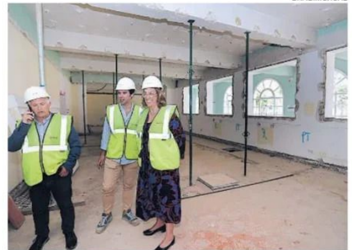
Ángeles Armisen contempla los trabajos en el edificio
